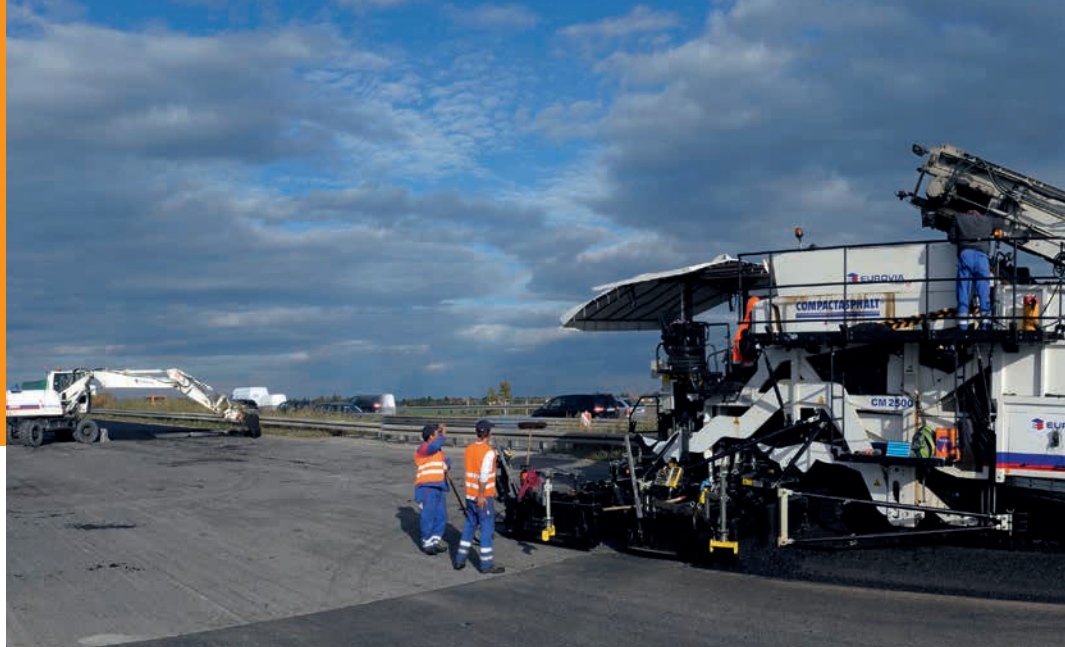
Innovatives Verfahren: Kompaktasphalt
